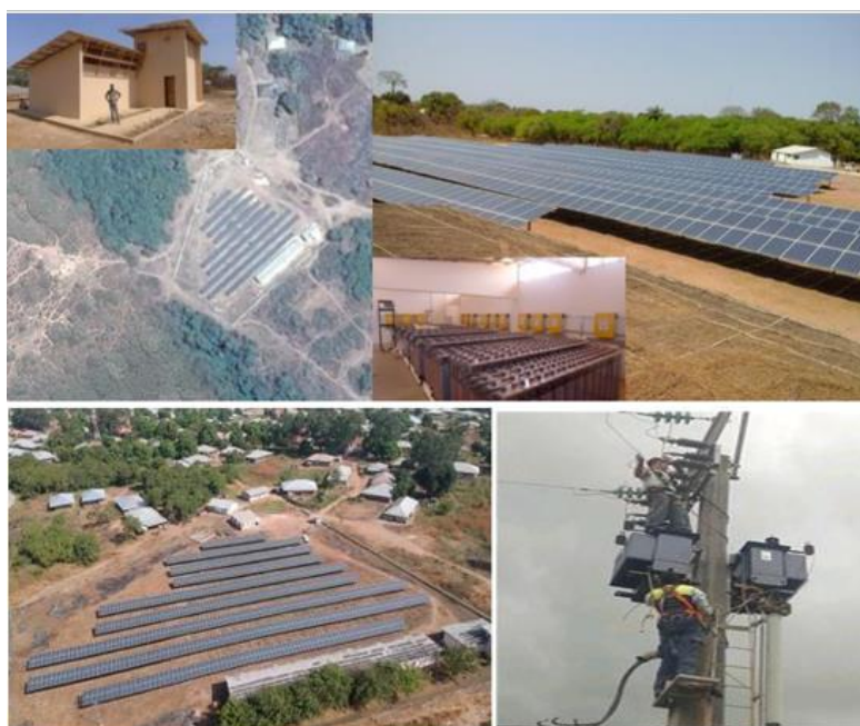
Figura 11- Mini-rede de geração Fotovoltaica de Bambadinca
