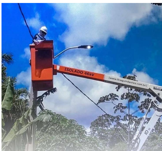
Figura 11: Troca de Lâmpadas - 1
