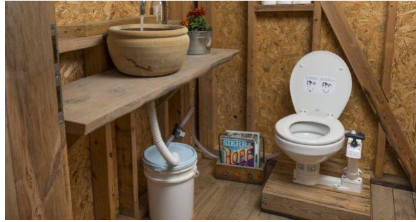
Figura 21 – Exemplo de Bio-toilet visão interna.
