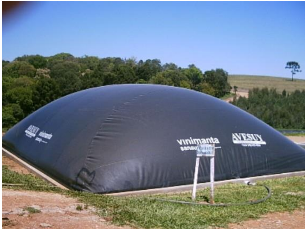
Figura 6 – Representação do biodigestor canadense.
