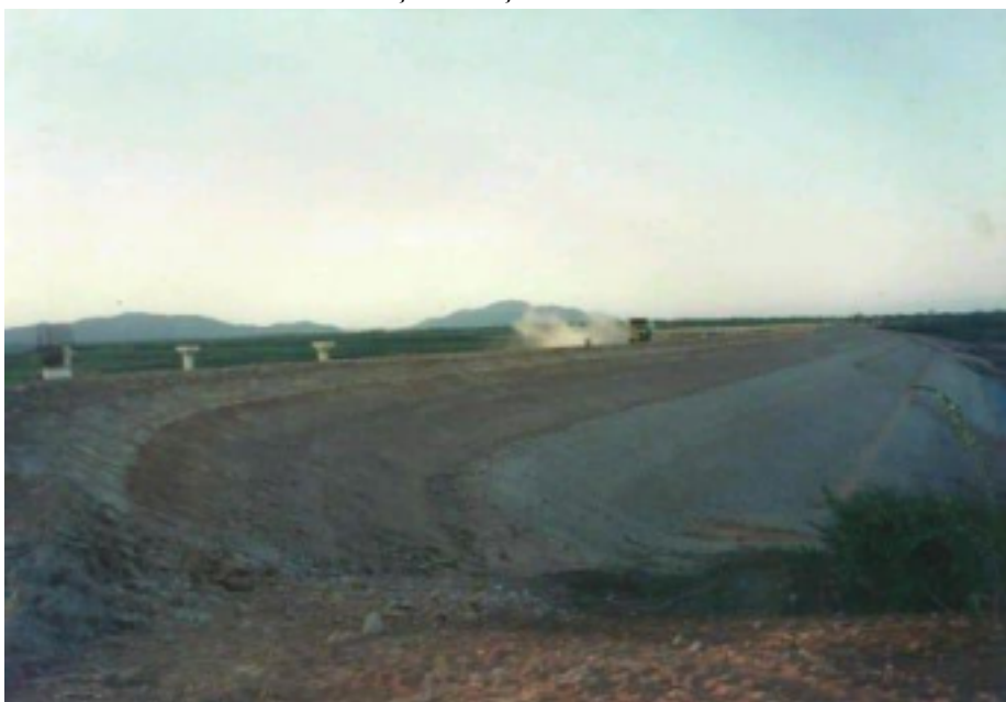
FIGURA 1: A Construção do Açude Aracoiaba - 2002
