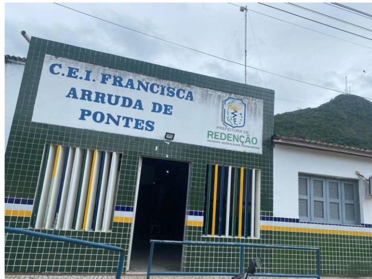
Figura 1 - Foto da fachada da escola
