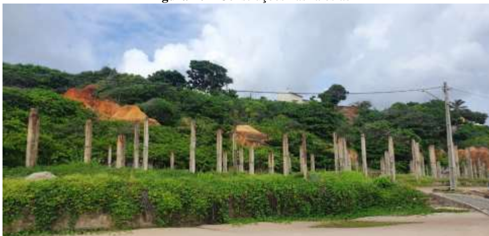
Figura 10 – Construções nas falésias
