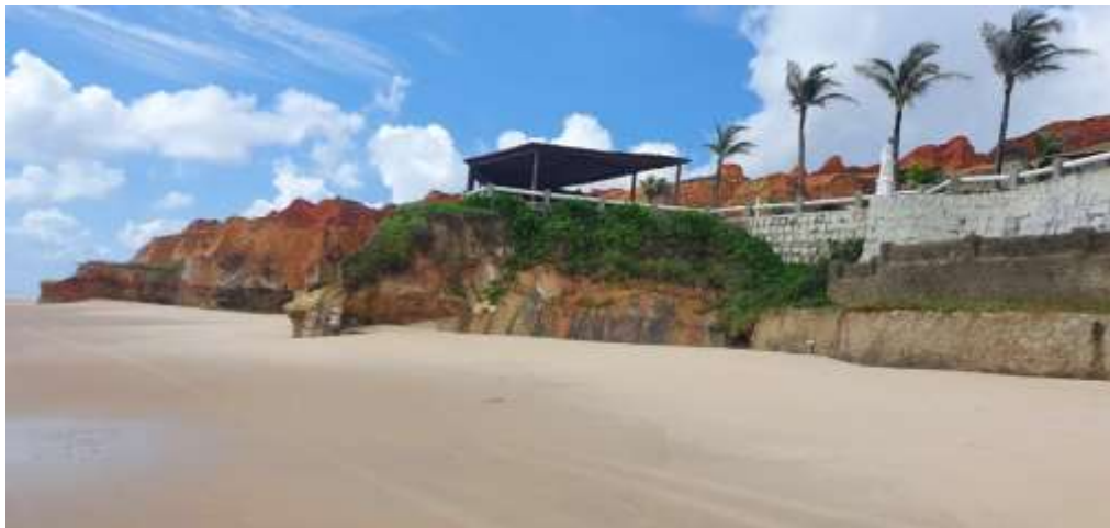
Figura 9 – Construções nas falésias
