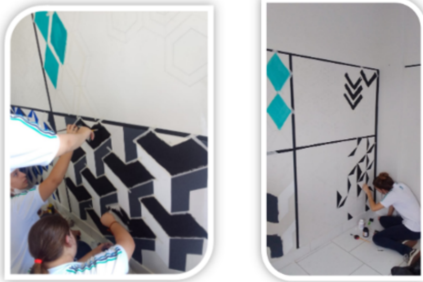
Figura 53 - Acabamento de painéis tesselação
