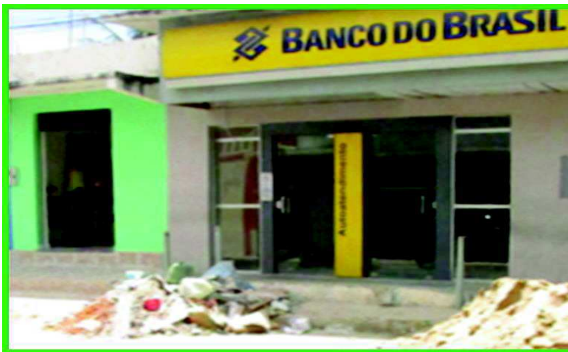
Figura 6 – Centro de Barreira, vias interditados pelos despejos.
