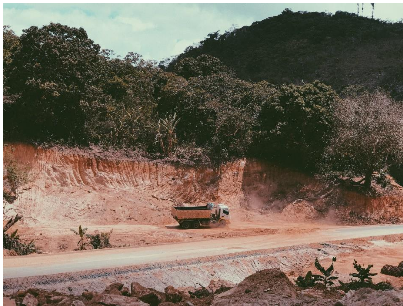
Foto 01 – Construção da CE-253, que liga Redenção a Pacoti
