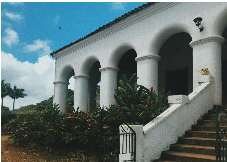
Foto 02- Fachada da casa do sítio São Luís
