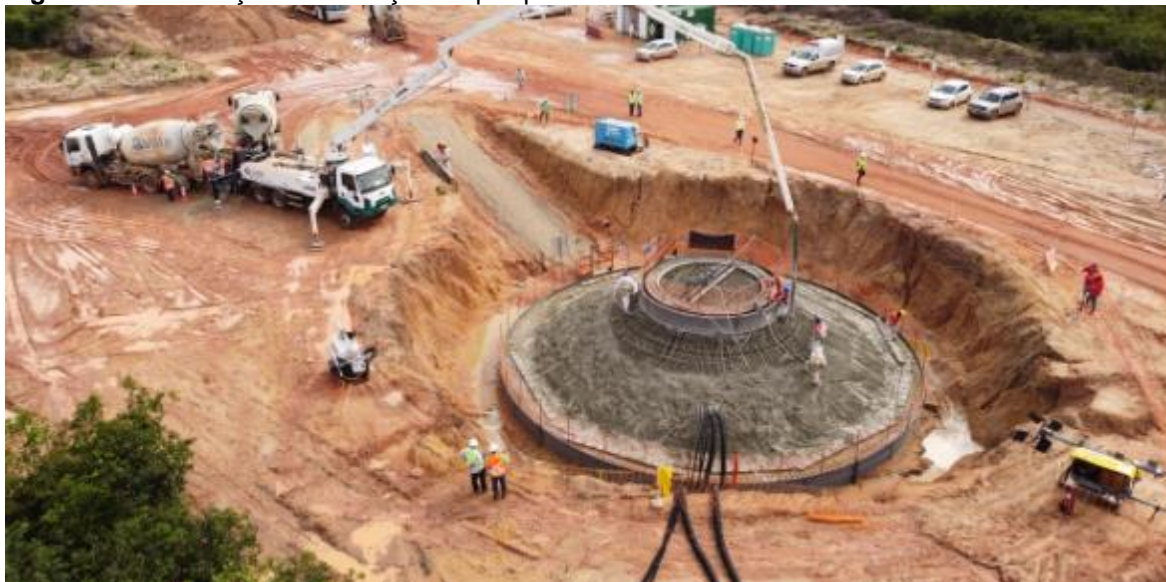
Figura 17: Construção da fundação de parque eólico em Trairi
