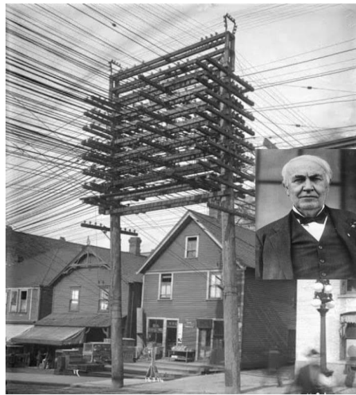
Figura 2- Cabos elétricos em Nova York no final do século XIX
