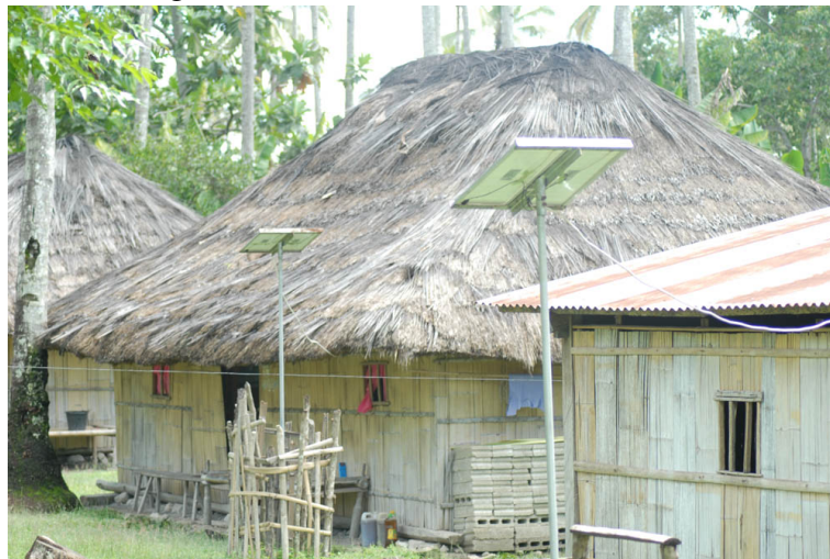
Figura 3 – Painéis Solares Instalados
