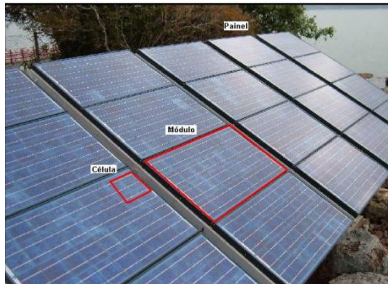
Figura 1 - Representação Esquemática De Células, Módulos e Painel Fotovoltaico
