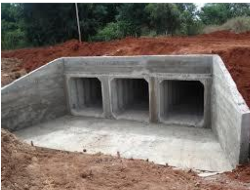
Figura 2.1: Bueiro Celular Triplo
