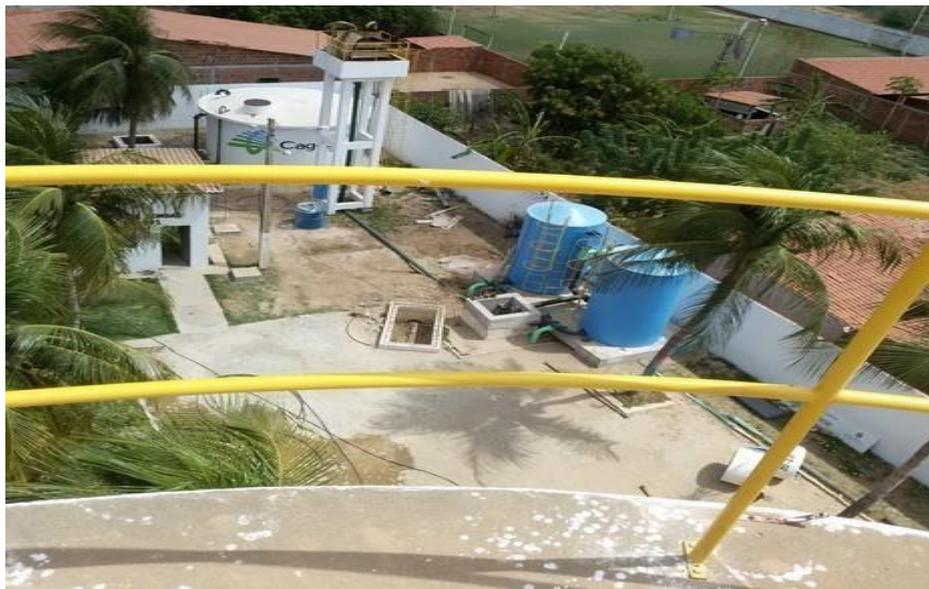
A reservação da água, do SAA é composta de 01 (um) reservatório apoiado e 01 reservatório elevado, localizados na ETA. A reservação inicial é o RAP – 01 (Figura 03), com capacidade de 50 m<sup>3</sup>, com função de reunião. Em seguida, a água é bombeada para o REL-01(Figura 04), com capacidade de 57 m<sup>3</sup>, com função de distribuição e reservação para lavagem do filtro.
