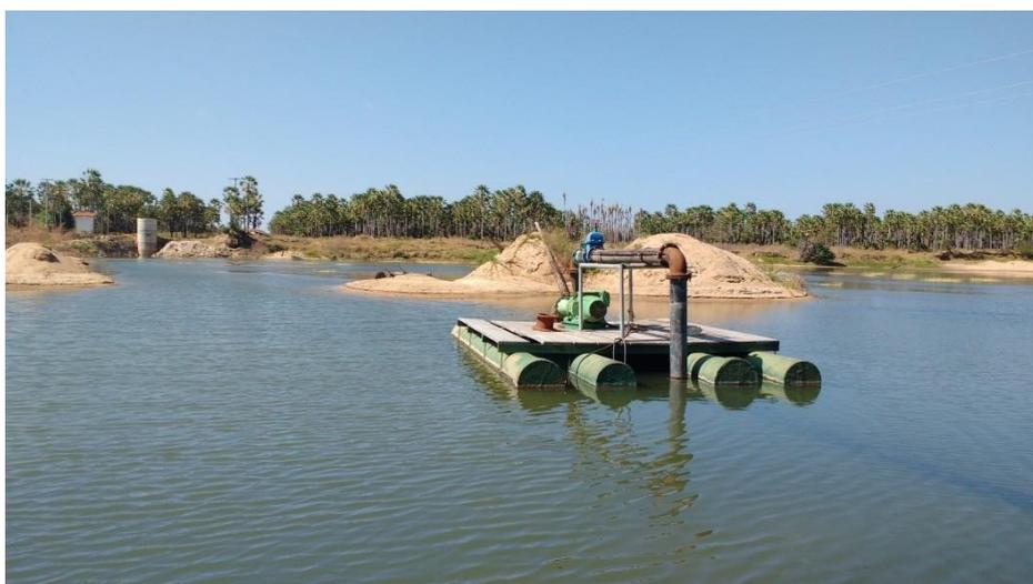
Figura 6: Flutuante utilizado para captação.
