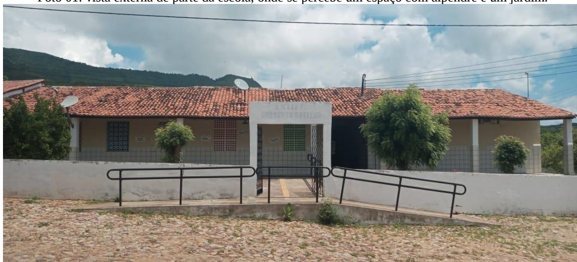
Foto 01: vista externa de parte da escola, onde se percebe um espaço com alpendre e um jardim.
