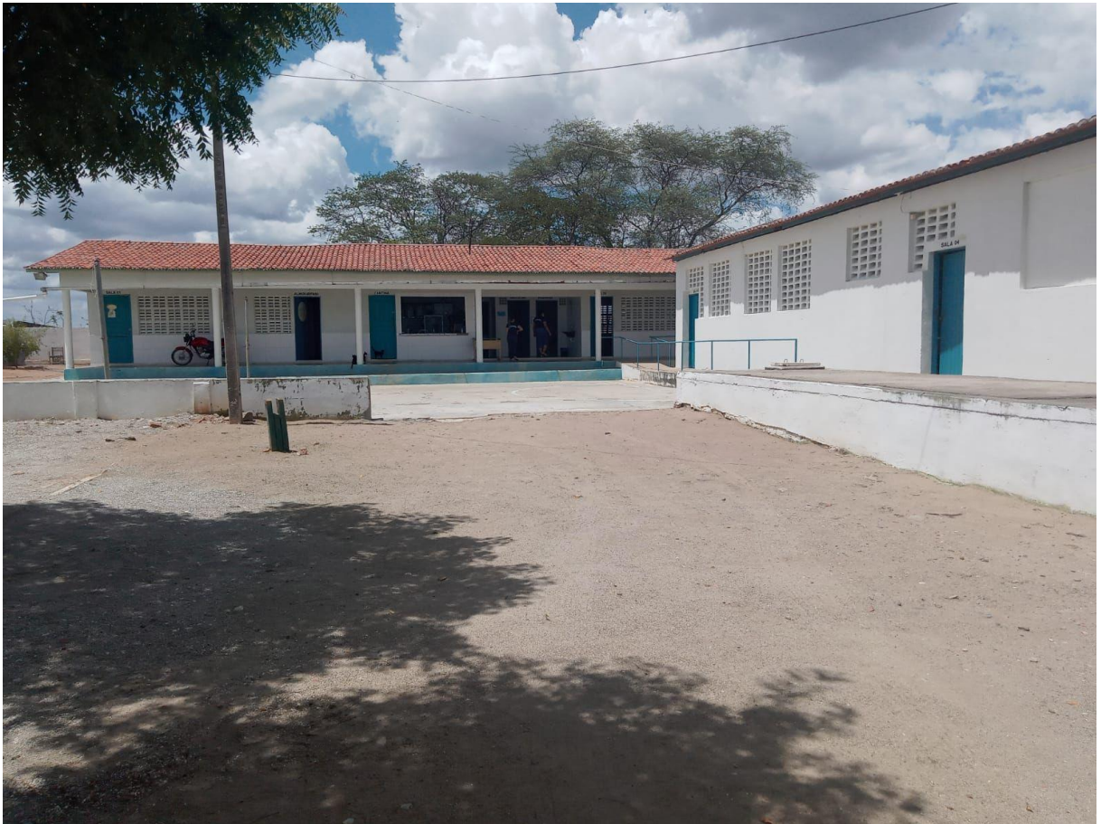
FIGURA 02 – Interior da Escola
