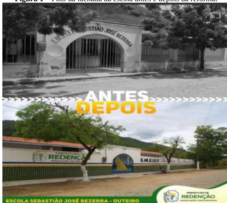
Figura 1 – Foto da fachada da escola antes e depois da reforma.
