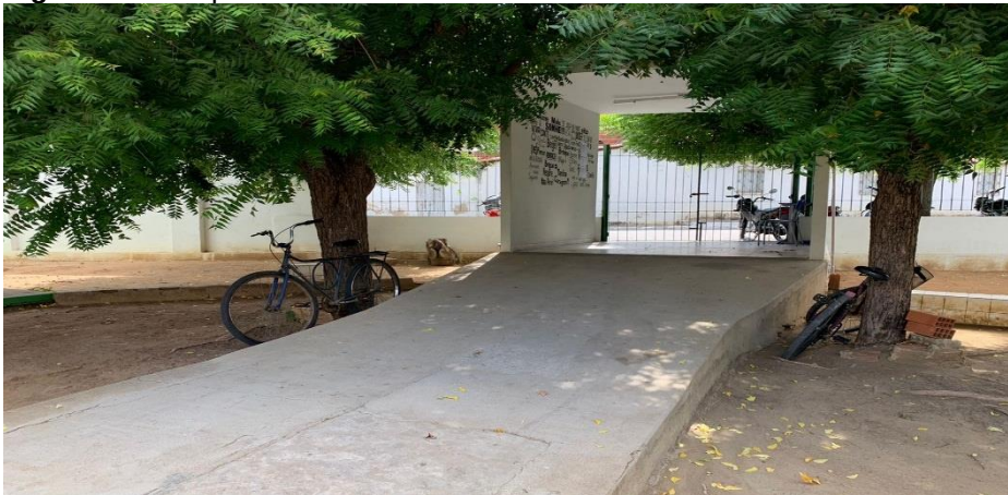
Figura 2 – Rampa de acesso da entrada da Escola
