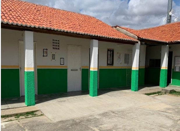
Figura 1 – Rampa de acesso lateral
