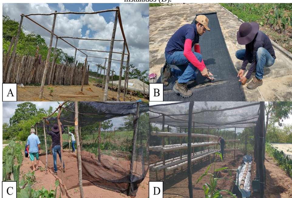
Figura 7 – Estacas fixadas, armação montada (A), corte em medidas do sombrite (B), cobertura da armação com sombrite 70% (C), estrutura coberta com canos instalados (D).
