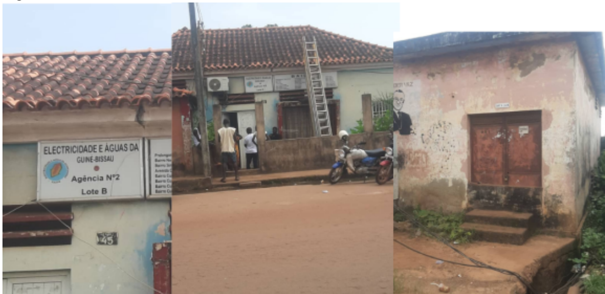
Figura 8 – Infraestruturas e materiais obsoletos nas ruas de Bissau .
