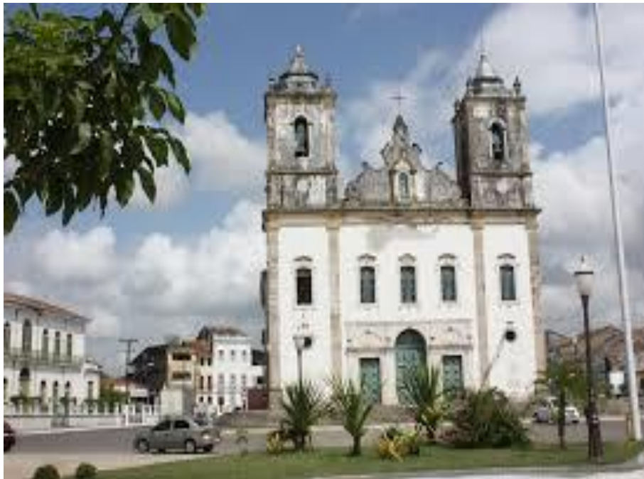
Figura 10: Praça da Purificação. Fonte: JF Paranaquá (2012)
