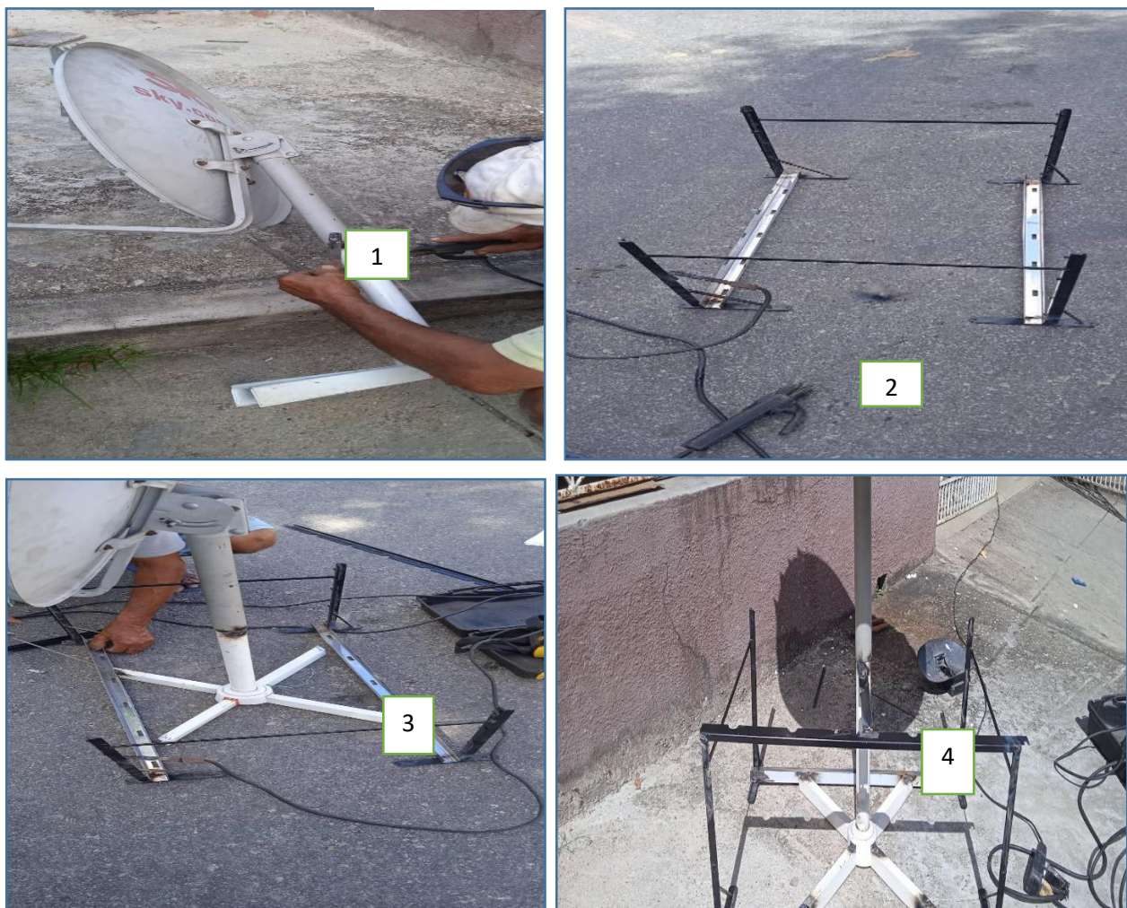
Figura 9- construção da estrutura da base
