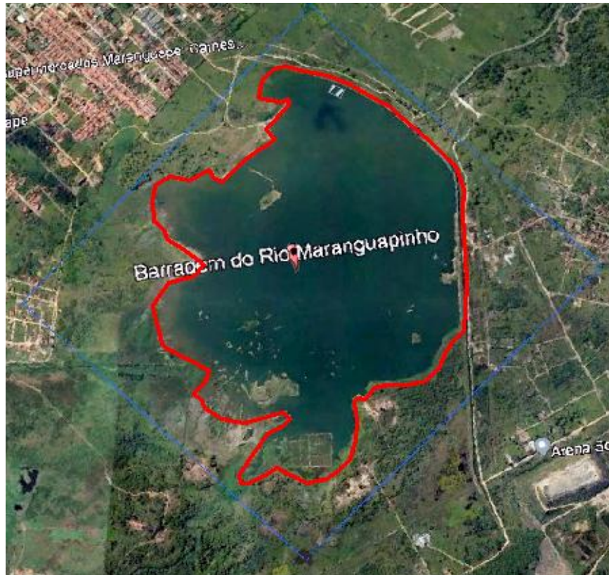
Figura 16: Reservatório da barragem do rio Maranguapinho via satélite.
