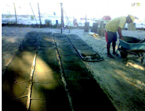
Figura 18 - Confeção das placas utilizadas na construção do Biodigestor Fonte: a autora
