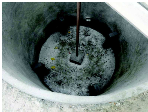
Figura 23 - Construção dos batentes de sustentação da câmara de biodigestão Fonte: a autora
