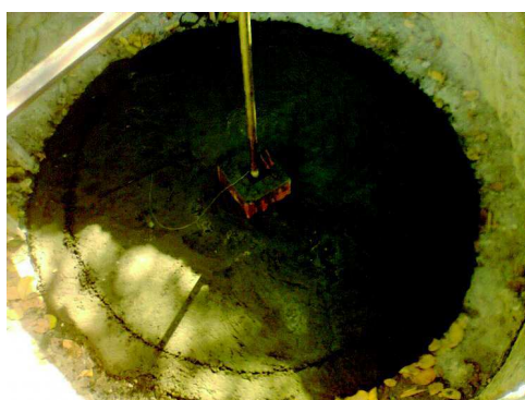
Figura 20 - Cano guia fixado no centro da estrutura principal do biodigestor Fonte: a autora
