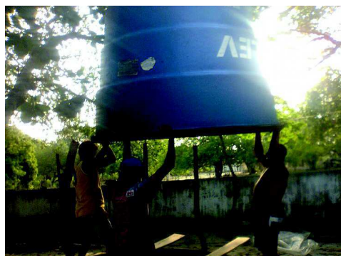
Figura 26 - Câmara do biodigestor – caixa de fibra
