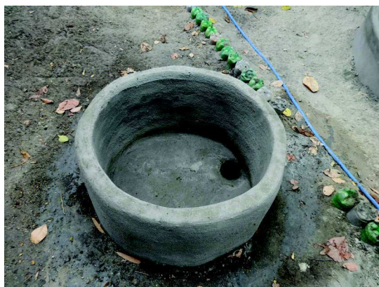
Figura 24 - caixa de carga do biodigestor
