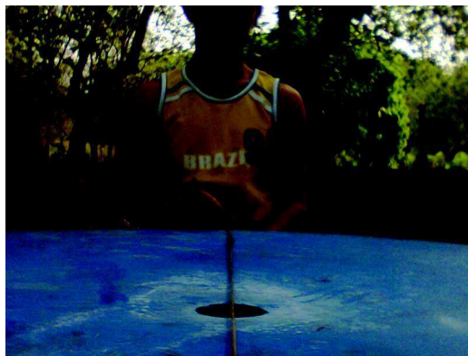
Figura 27 - Ponto central na caixa de fibra para instalação do cano guia Fonte: a autora
