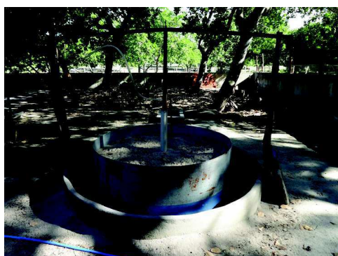
Figura 21 - Barrote instalado para servir de trave de segurança Fonte: a autora
