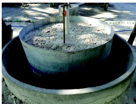
Figura 30 - Lastro de zinco instalado sobre a caixa de fibra Fonte: a autora
