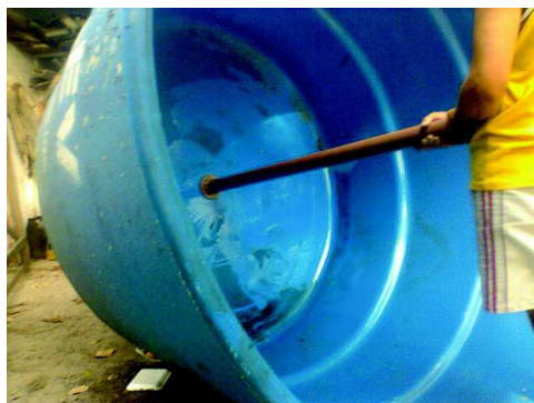
Figura 28 - Instalação do cano guia Fonte: a autora
