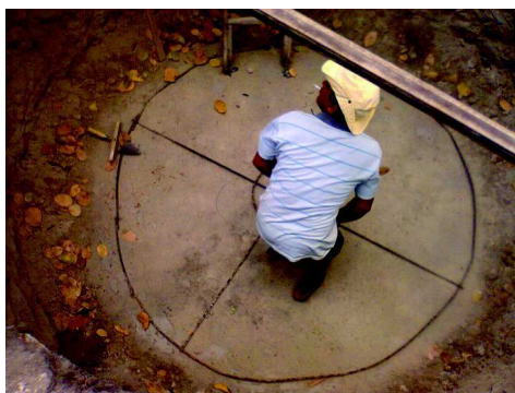
Figura 19 - Nivelamento do buraco para construção do piso do biodigestor Fonte: a autora
