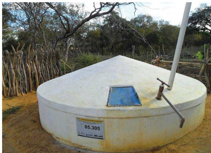
Figura 1. Fotografia de uma cisterna de placas, utilizada para armazenamento de água das chuvas.
