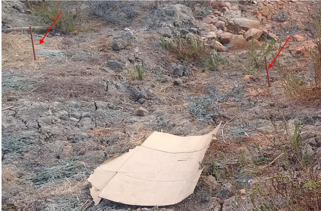
Figura 20 – Instalação de pinos de erosão confeccionados a partir de vergalhões de ferro de meia polegada, com detalhe do trecho do maciço que colapsou em abril de 2020.
