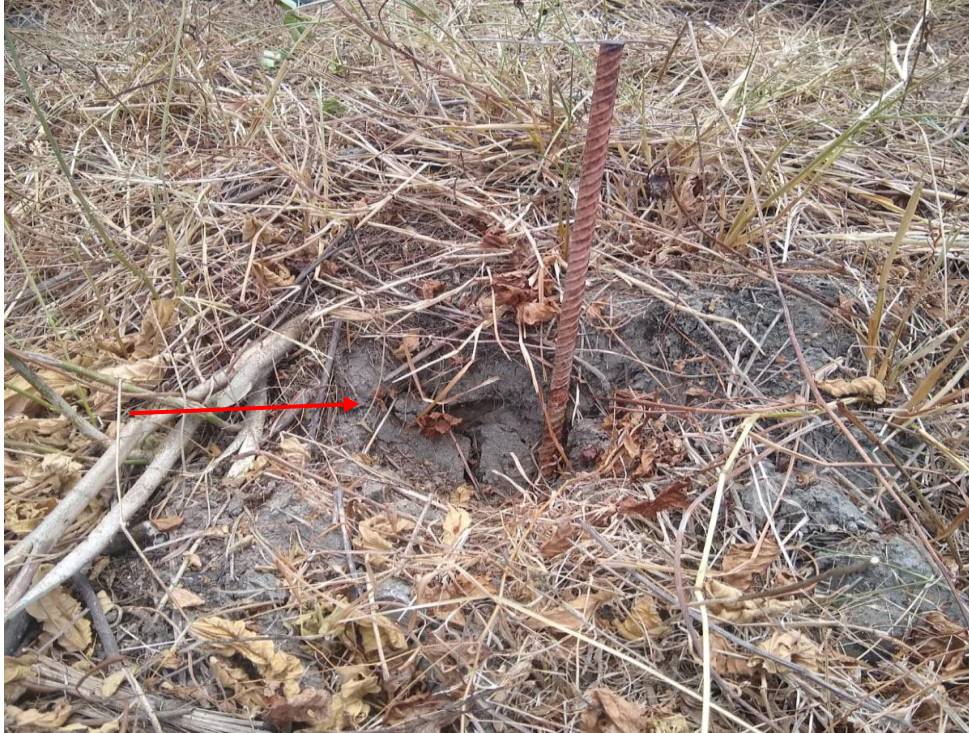
Figura 21 – Erosão a esquerda do pino implantado no leito do rio
