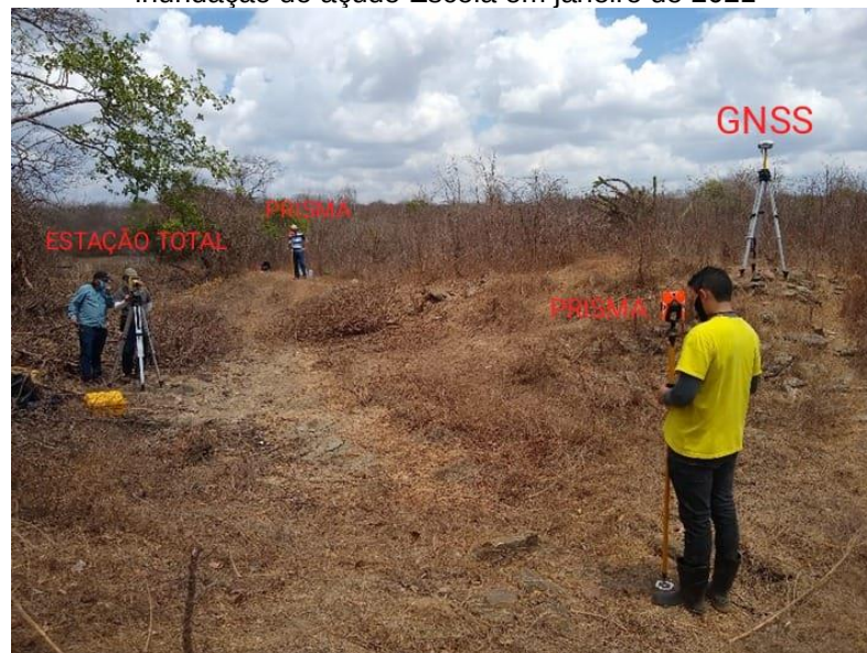
Figura 5 – Detalhes da estação total e GNSS em operação no levantamento topográfico da área de inundação do açude Escola em janeiro de 2021
