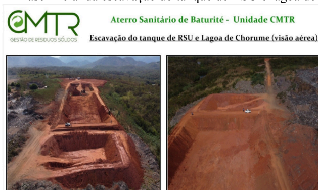
Figura 2 – Fase inicial da escavação do tanque de RSU e lagoa de chorume.
