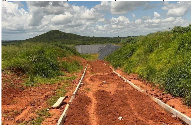
Figura 5 – Pavimentação da estrada que leva ao tanque de RSU.
