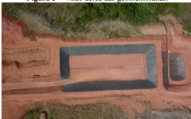
Figura 3 – Visão aérea das geomembranas.
