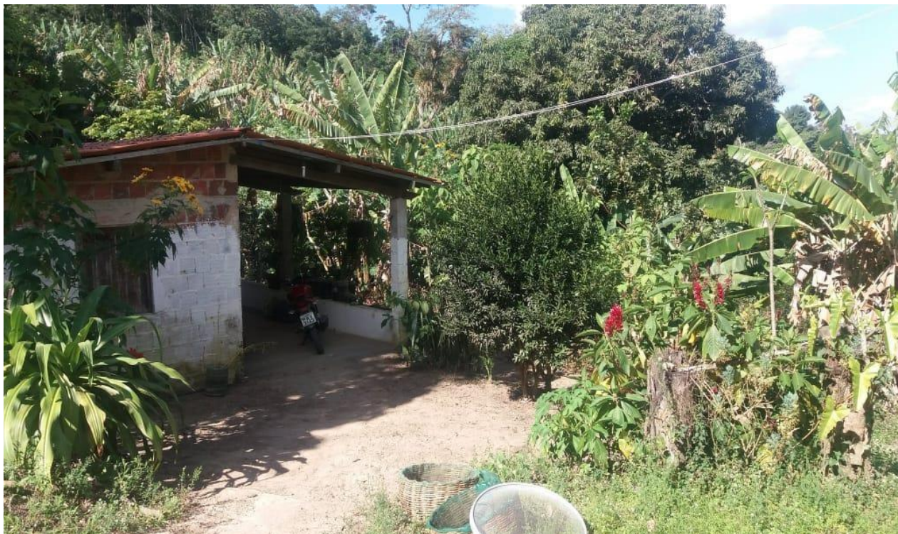
Figura 20 - Casa para trabalhadores construída no sítio de Dirlan
