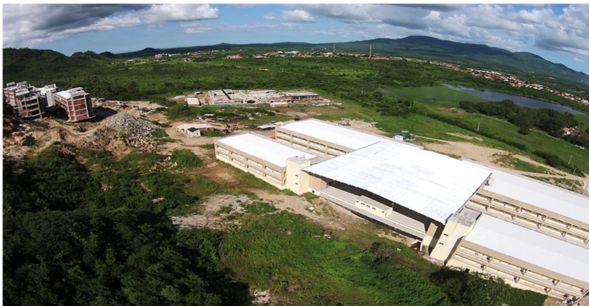
Figura 15 - Imagem Aérea destacando cobertura do Bloco Didático no Campus das Auroras
