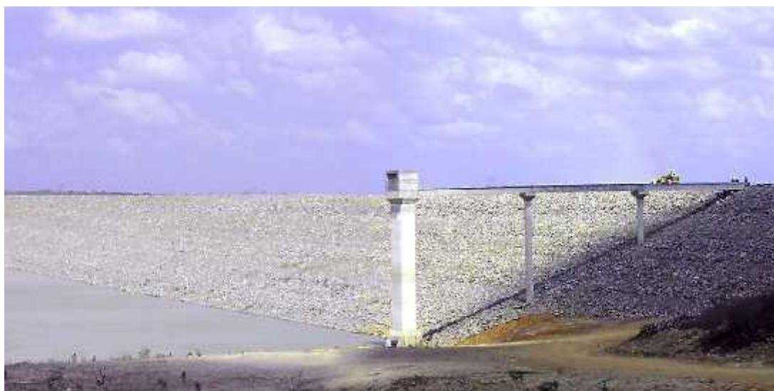
Foto 07: Açude Aracoiaba após ser finalizado
