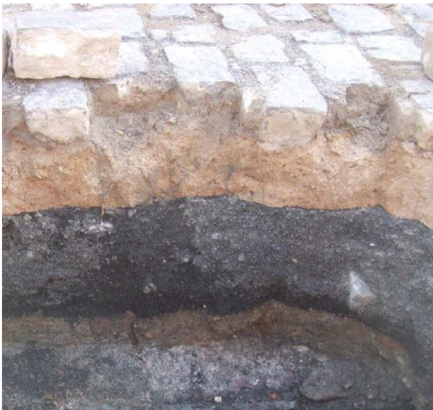
Figura 4 - Escória utilizada na pavimentação no município de Santo Amaro
