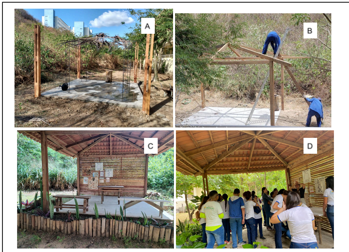
Figura 4: (A) Início da construção do espaço de apoio. (B) Estruturação do telhado. (C) Construção concluída. (D) Local em uso, recebendo visitantes.
