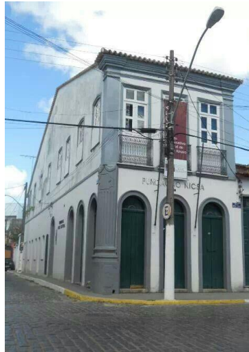
Figura 2 - Sobrado do NICSA e antiga biblioteca Pe. Loureiro – Fundação José Silveira, em Santo Amaro reformado desde a década de 1980
