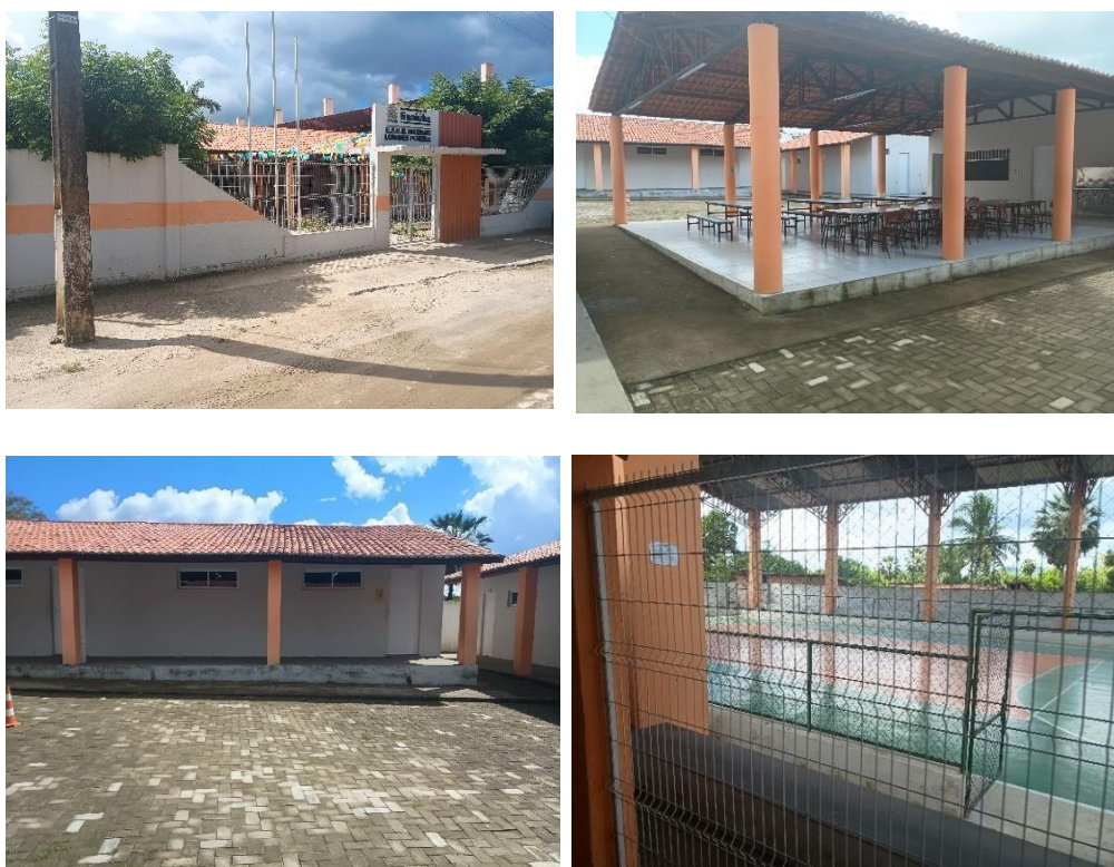
Figura 2: imagens do prédio da escola
