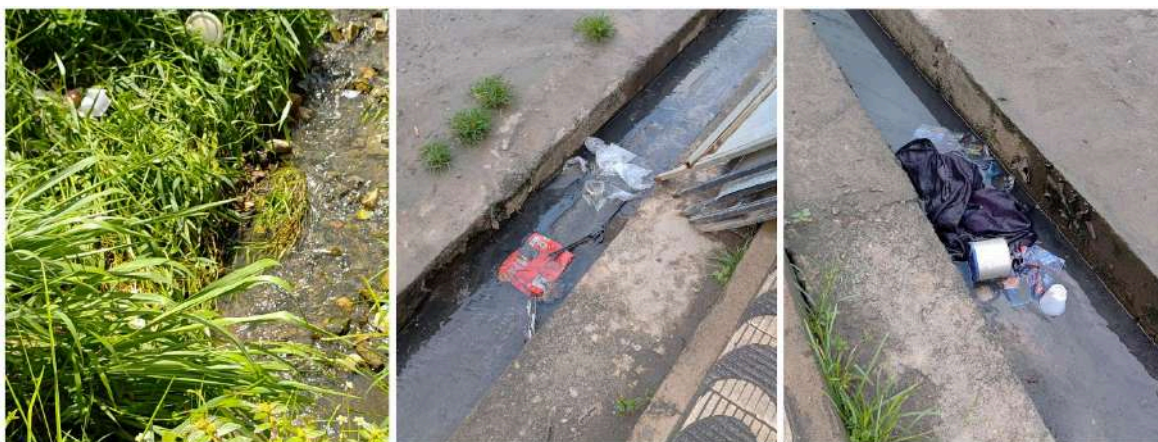
Figura 13 – Fotografias de resíduos e esgoto a céu aberto em Redenção-CE
