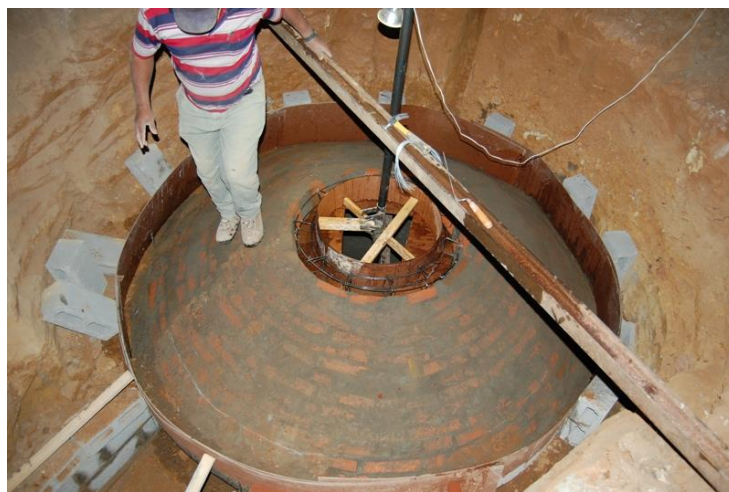
Figura 3 - Biodigestor Chinês em construção
