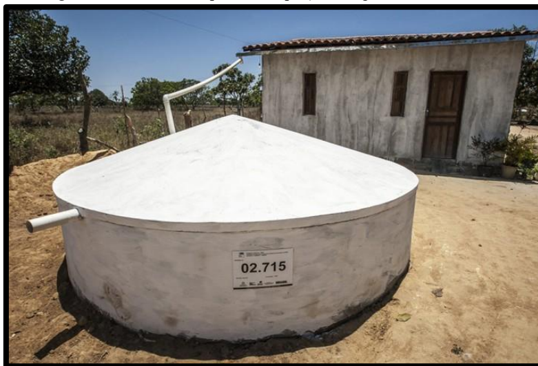
Figura 05: Cisterna de placa de captação de água de chuva (CBIC, 2019).
