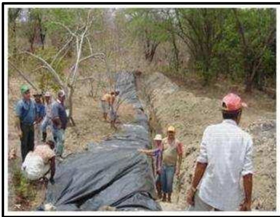
Figura 07: Barragem subterrânea submersível, modelo EMBRAPA, com cordões de contorno na bacia hidráulica (LIMA et al. , 2013).
