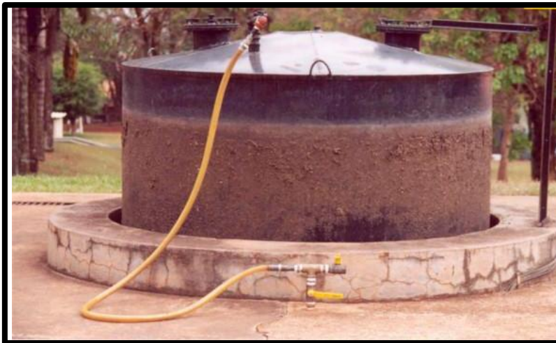
Figura 13. Modelo de biodigestor em batelada
