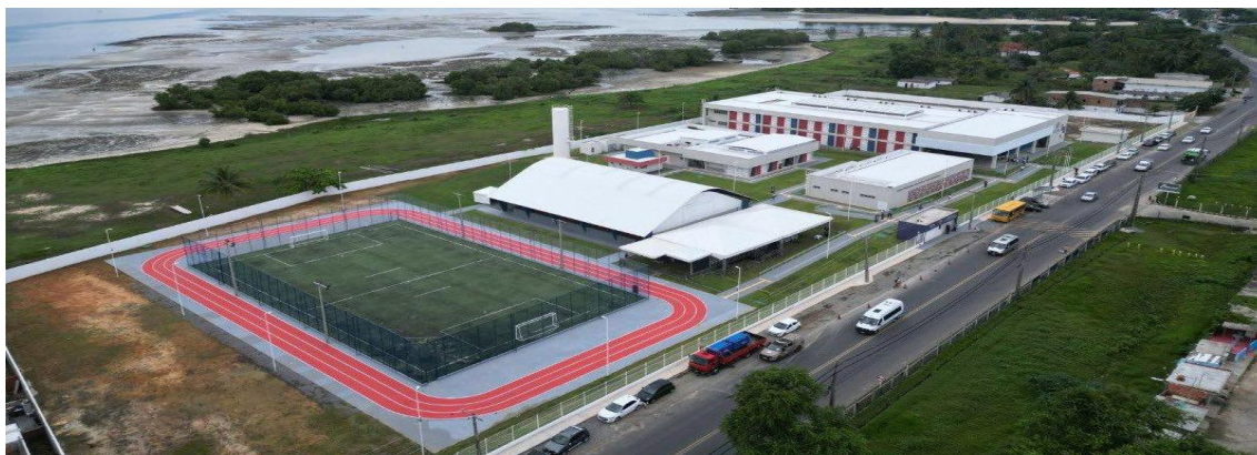
Figura 3: Vista aérea do novo prédio estrutural do Colégio
