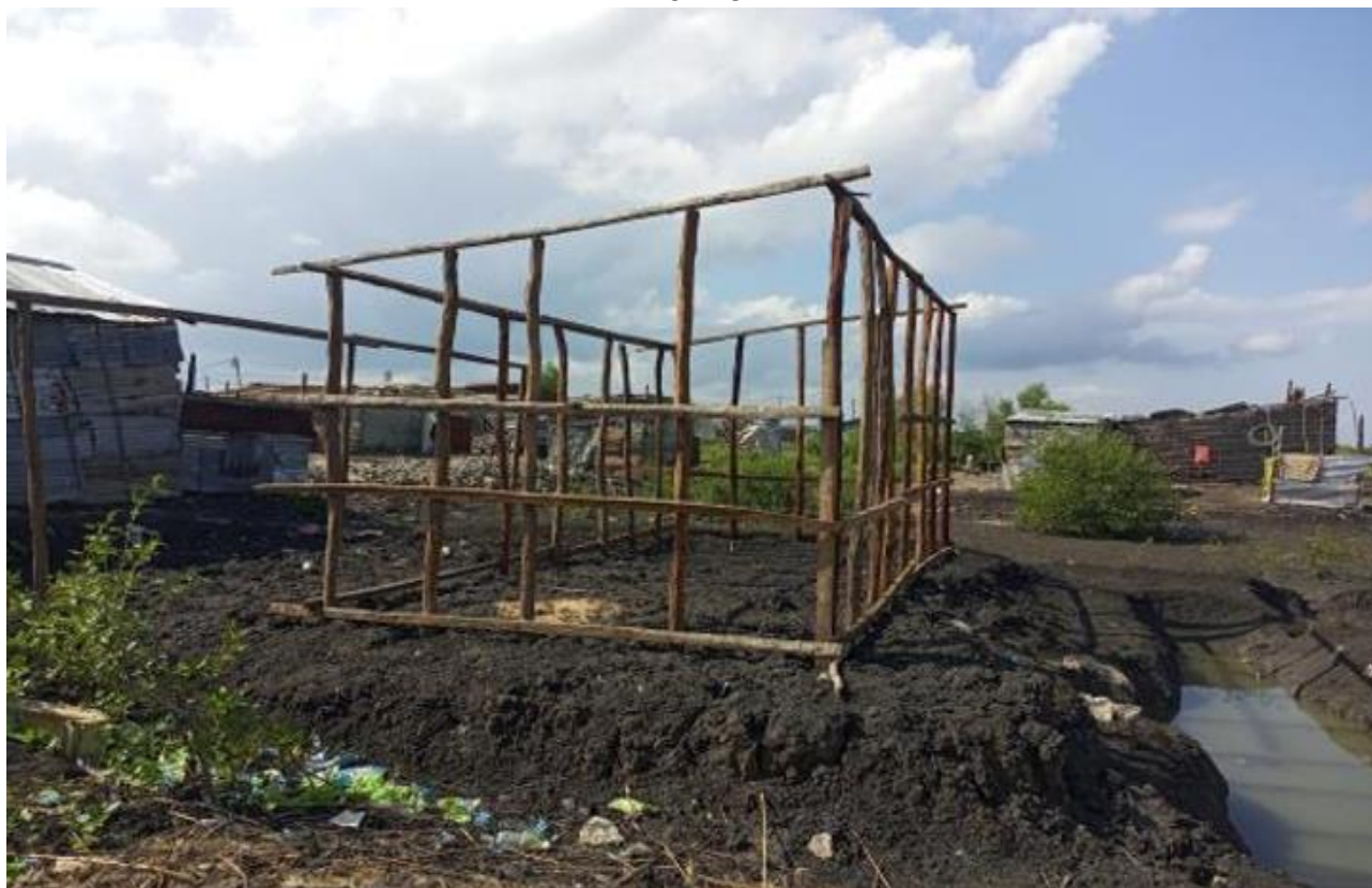
Figura 7. Construção de novas casas ao longo do quarteirão R – Interior do Bairro
