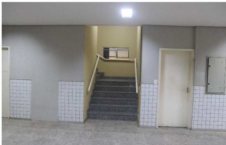
Fotografia 6 - Escadas de acessibilidade às salas de aula (Auroras)
