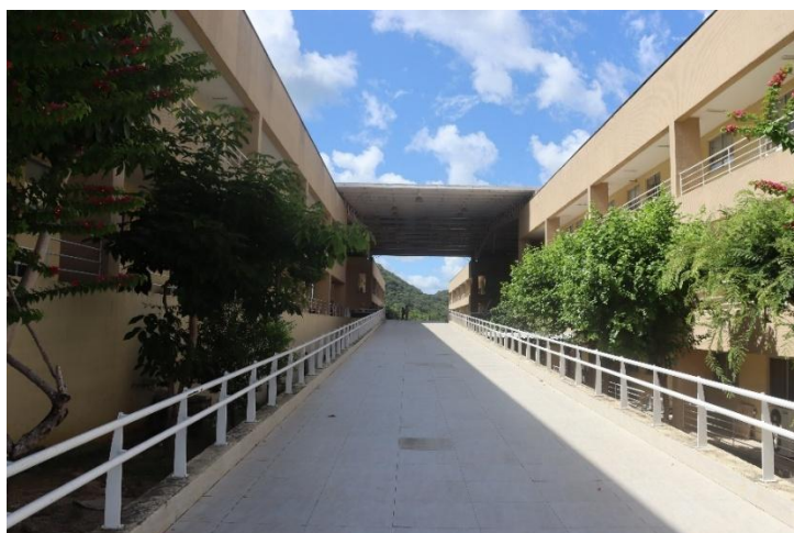
Fotografia 4 - Rampa de acesso ao pátio - Auroras
