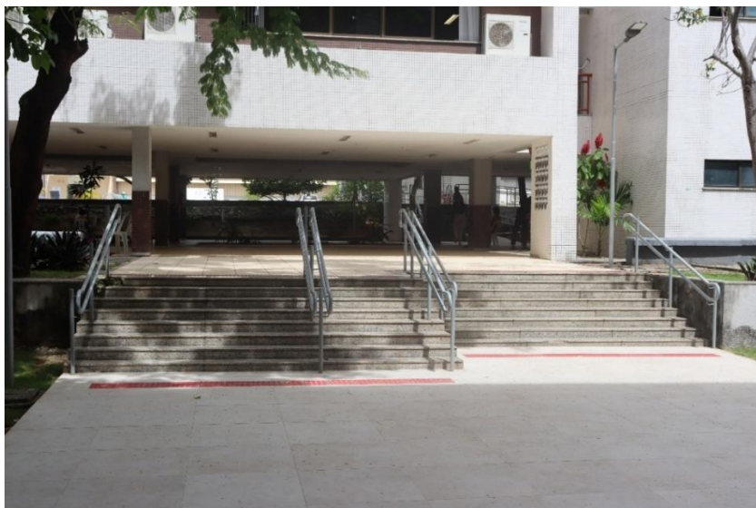
Fotografia 8 - Escada de acesso aos blocos de salas de aula (Palmares)
