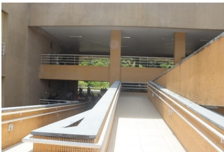
Fotografia 1 - Rampas de acesso às salas de aula (Auroras)
