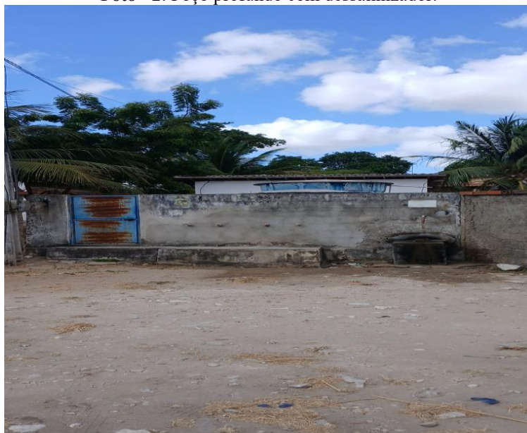
Foto - 2: Poço profundo com dessalinizador.
